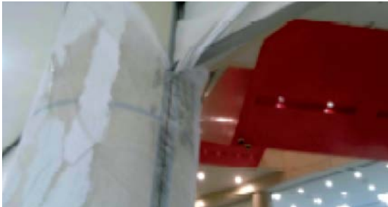
2층 롯데쇼핑 방화스크린 장애물 설치
