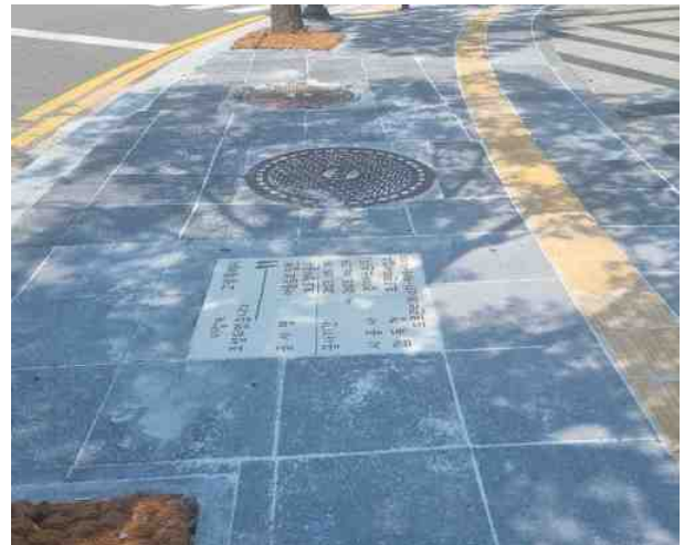
덕양구 화정동 어울림로 일원 보도정비 (공사이력판 설치)
