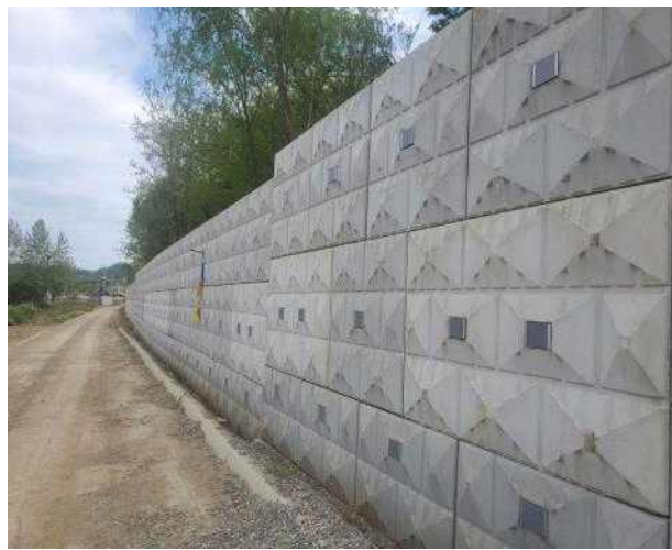
현장 사진(보강토 옹벽 보강 완료)
