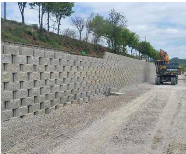
현장 사진(보강토 옹벽 설치)
