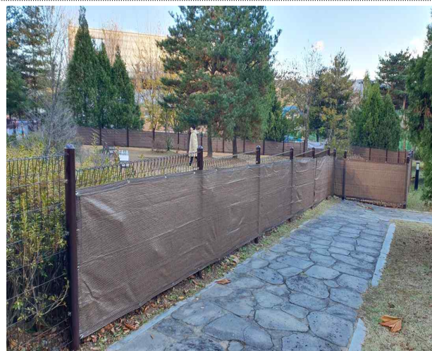
식사중앙공원 간이놀이터 설치
