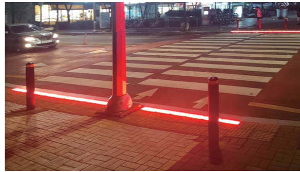
#4 보행 안전을 위한 횡단보도 LED 바닥신호등 설치
